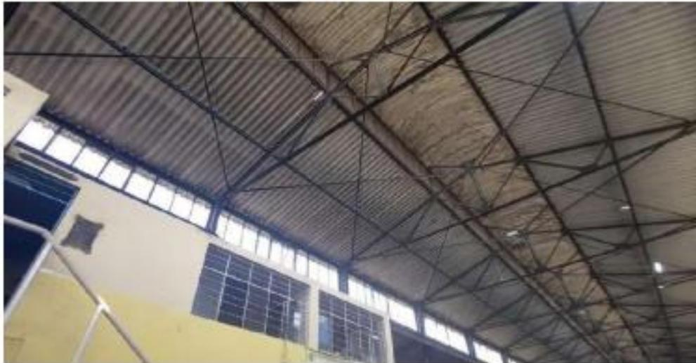
Fotografía N°2: Techo de Taller de Mecánica de Producción. Se realizará mantenimiento de la estructura metálica y se reemplazarán las coberturas.
